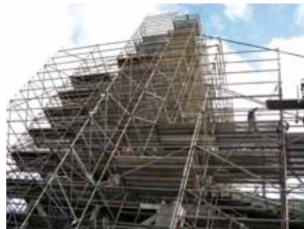
Échafaudage en cours de réalisation
