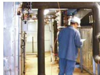
Contrôle de travaux dans une centrale d'air
